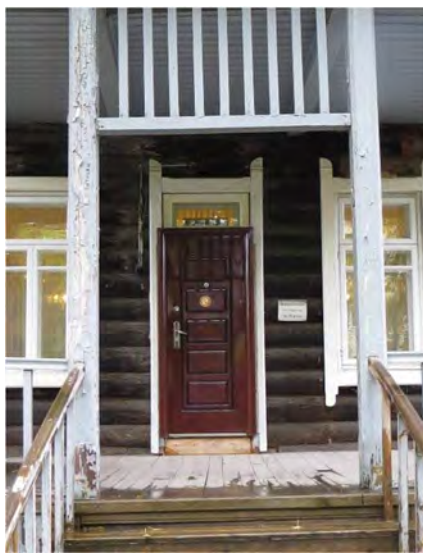
Рис. 9. Дом по адресу г. Томск, пр. Кирова, 7. Фрагмент южного фасада. Фото 2015 г.
