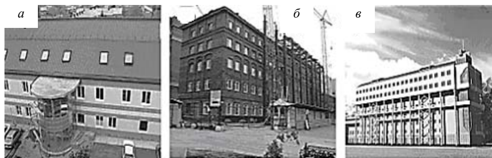
Рис. 5. Примеры возведения в зданиях дополнительных этажей:
