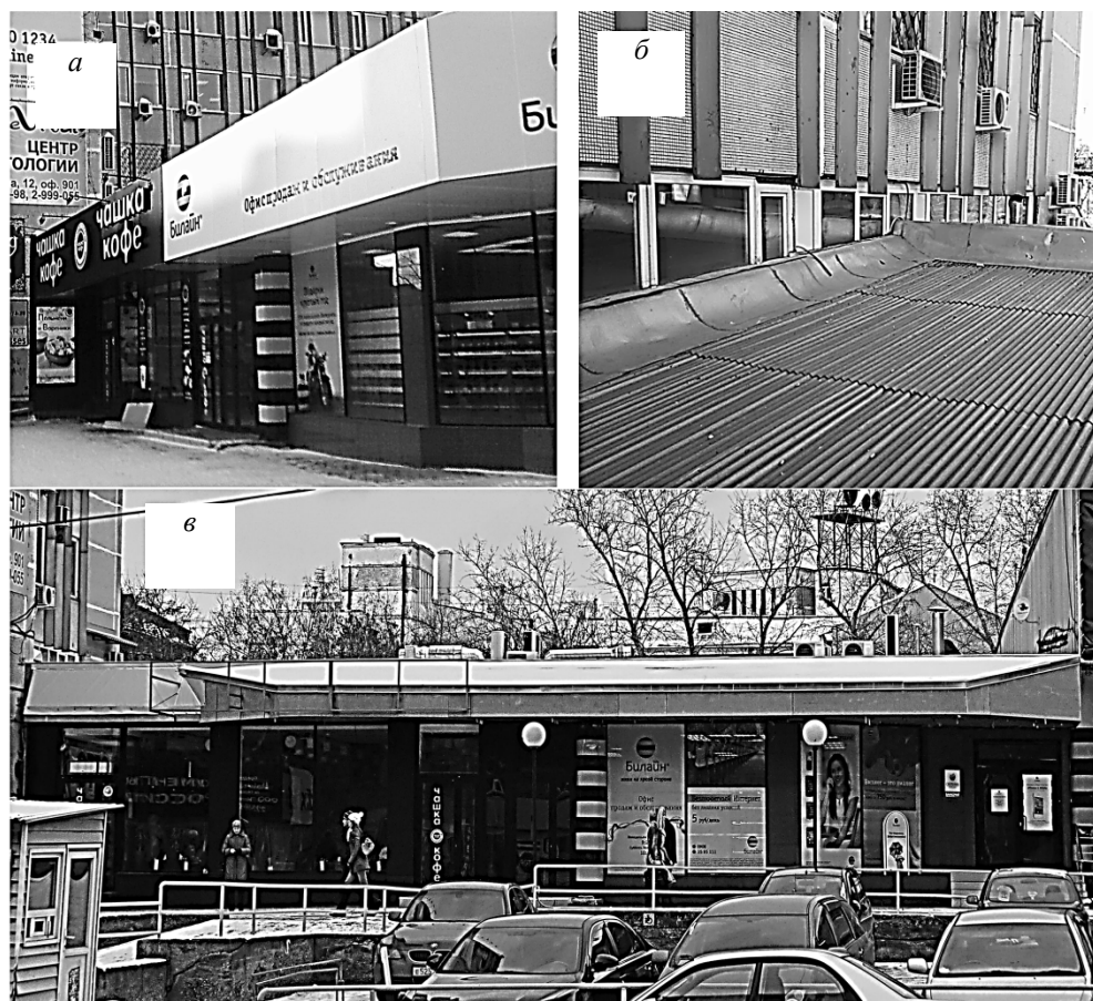
Рис. 6. Перекрытие кровлей пристройки кафе оконных проемов многоэтажного здания: а и в – главный фасад здания до и после реконструкции; б – положение кровли до реконструкции
