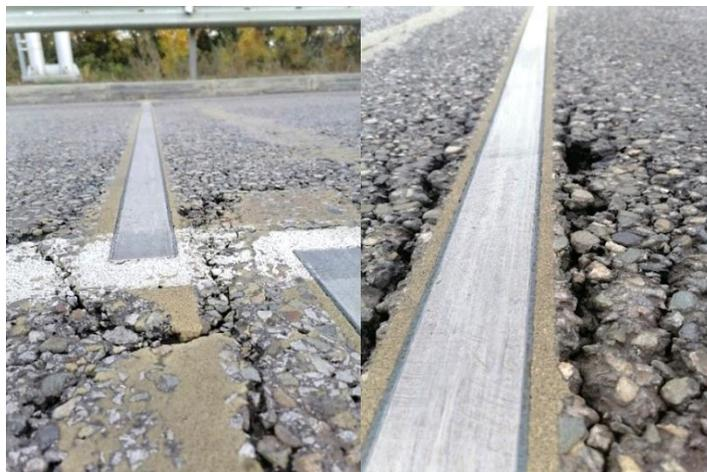
Рис. 3. Дефекты проезжей части в зоне весоизмерительных датчиков
