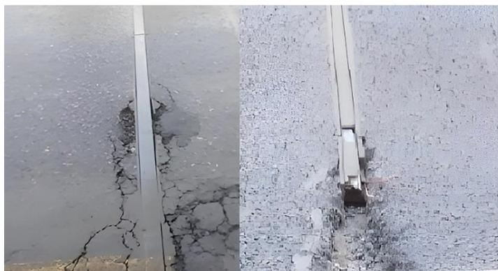
Рис. 4. Разрушение покрытия и весоизмерительного датчика
