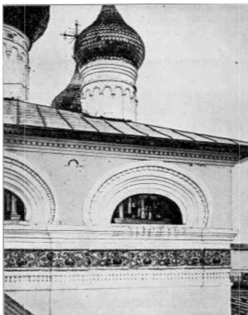
Рис. 2. Юрьевец. Детали фасада Благовещенской церкви, 1700 г. Fig. 2. Facade of the Annunciation Church in Yurievets, 1700
