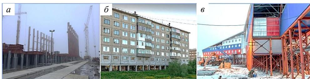
Рис. 3. Свайный фундамент на Ямале<sup>13</sup> (а); жилой дом на забивных бетонных сваях<sup>14</sup> (б); пространственный несущий свайный каркас базы «Арктический трилистник»<sup>15</sup> (в)
