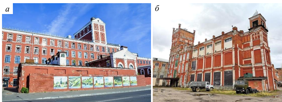
Рис. 8. Бумагопрядильная фабрика С. Морозова в Орехово-Зуеве 12 (а); современное состояние зданий и сооружений фабрики 13 (б)
