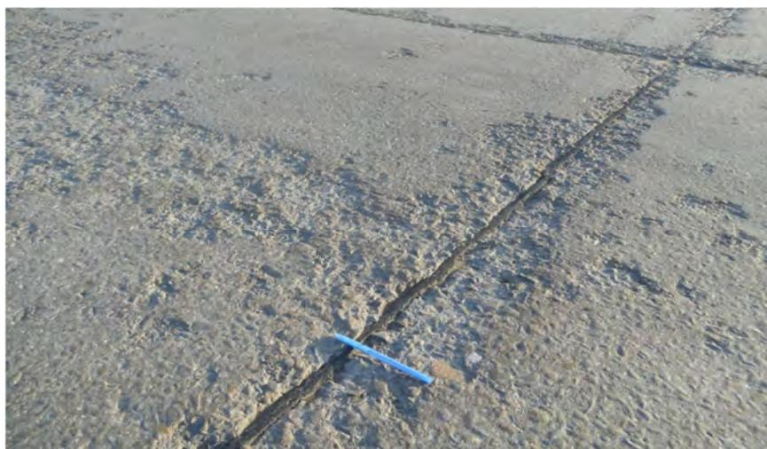
Рис. 2. Шелушение поверхности цементобетонного покрытия вдоль деформационных швов
