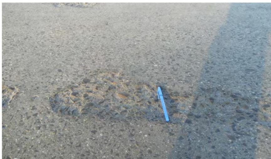
Рис. 1. Выбоины на поверхности цементобетонного покрытия
