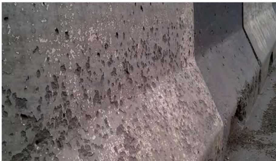
*Рис. 3.* Шелушение поверхности блоков дорожного ограждения
