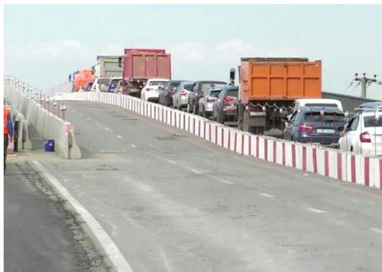
Рис. 1. Движение транспорта по половине проезжей части во время ремонта путепровода
