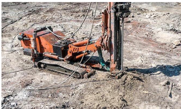
Рис. 6. Производство работ по технологии струйной цементации грунтов
