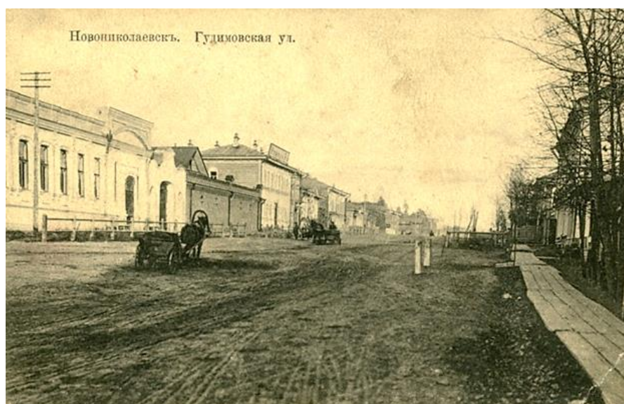
Рис. 3. Ново-Николаевск, ул. Гудимовская с оборудованными тротуарами для пешеходов и немощным дорожным полотном для проезда гужевого транспорта. Почтовая карточка 1910-х гг. 2
