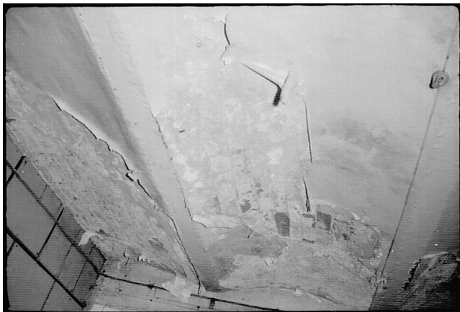
Рис. 14. Сводчатое перекрытие. Фото из архива СИ «Сибспецпроектреставрация», 1988 г. Fig. 14. Vaulted ceiling. Adopted from design documentation of "Sibspetsproekproektrestavratiya", 1988
