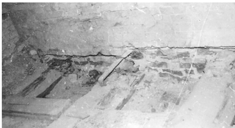
Рис. 6. Деревянное междуэтажное перекрытие с металлической скобой. ТГУ, I объём. Фото из архива СИ «Сибспецпроектреставрация», 1987 г., автор В.А. Кондратьев Fig. 6. Wooden floor with metal bracing. TSU. Adopted from design documentation of "Sibspetsproektrestavratiya", 1987
