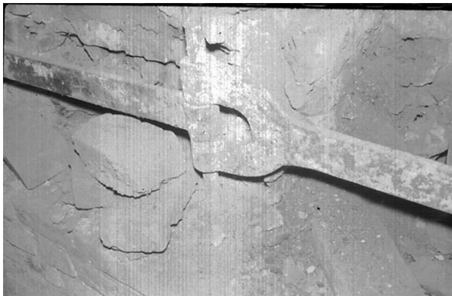
Рис. 8. Металлическая кованая затяжка. ТГУ. Фото из архива СИ «Сибспецпроектреставрация», 1987 г., автор В.А. Кондратьев
