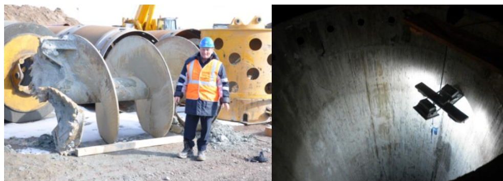
Рис. 10. Шнек для проходки скважин и монитор с подсветкой для исследования забоя скважины Fig. 10. Wellbore auger and backlit monitor for bottom-hole investigation
