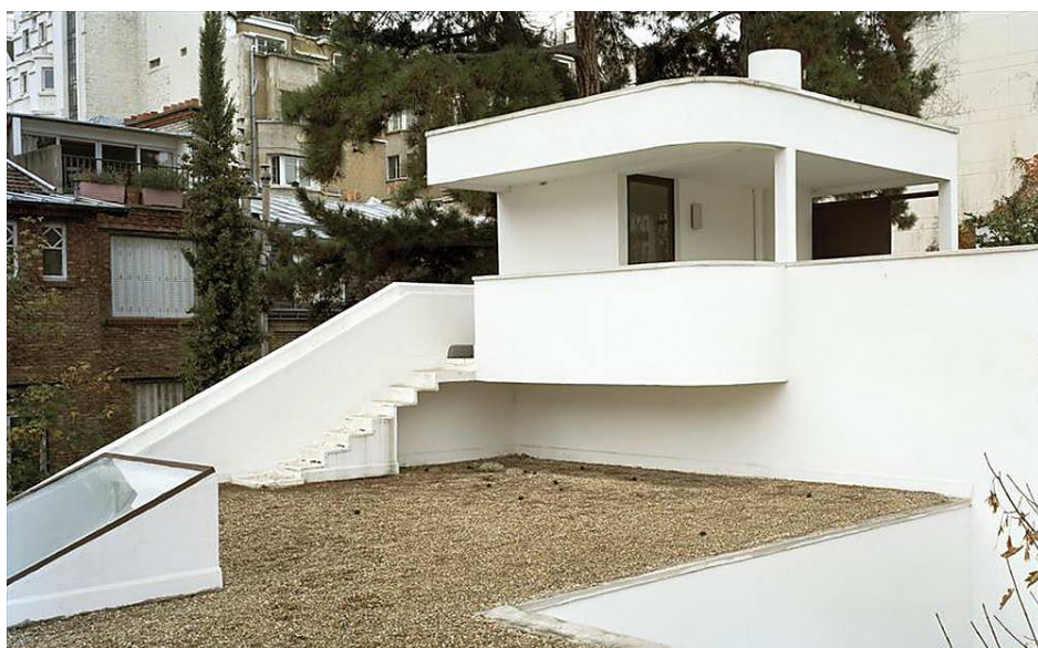
Рис. 12. Выход на плоскую крышу дома-студии Ла Роша 11 Fig. 12. Exit to the flat roof of the La Roche studio house
