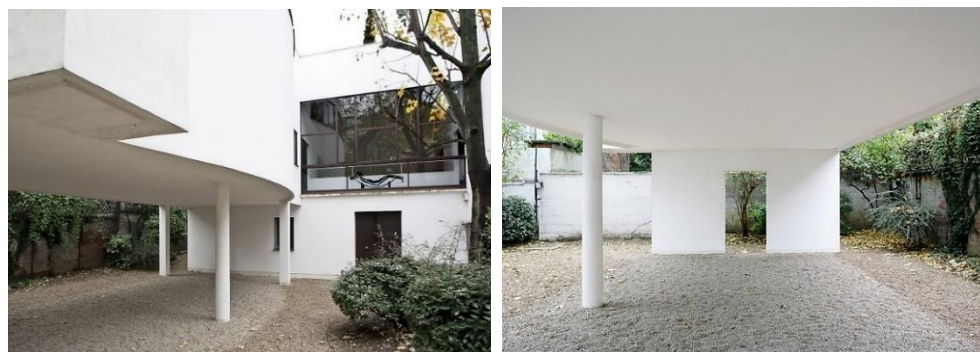
Рис. 13. Нижняя (опорная) часть дома-студии Ла Роша 12 Fig. 13. Lower (supporting) part of the Maison La Roche
