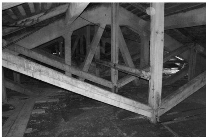
Рис. 8. Фото фрагмента висячей стропильной системы в здании библиотеки Томского Императорского университета
