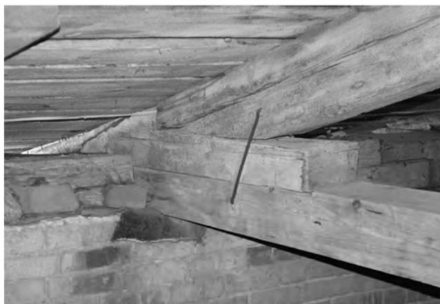
Рис. 3. Фото протеза опорной части стропильной ноги здания Томского Императорского университета
