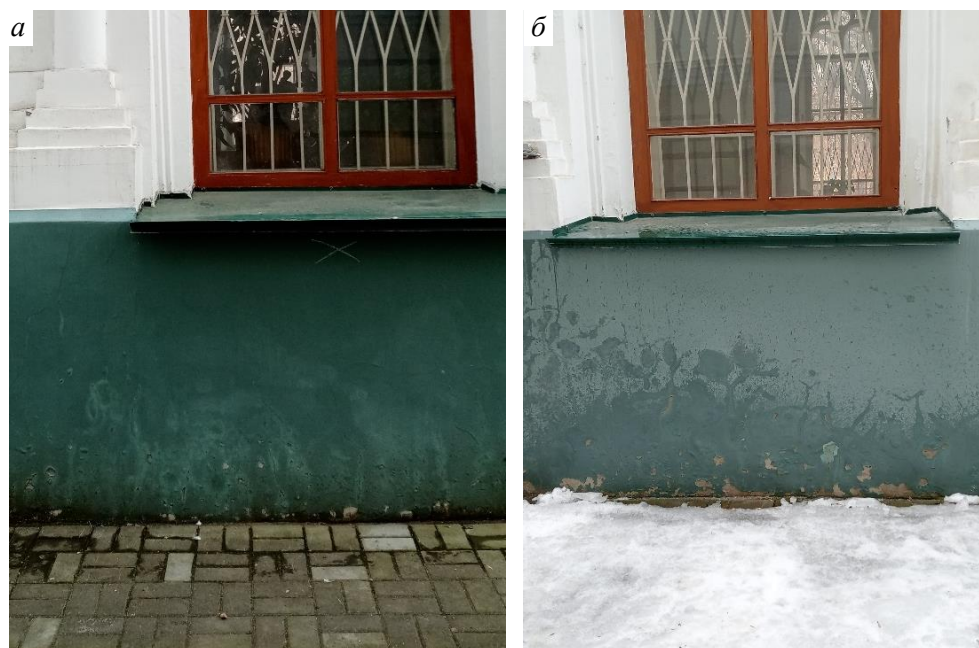
Рис. 4. Церковь Александра Невского в Томске. Пятна на поверхности цоколя. Фото А. Кутукова:
