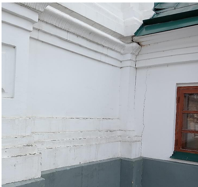
Рис. 6. Трещина в штукатурном слое по деформационному шву между основным объёмом церкви и тамбуром. Фото А. Кутукова, март 2023 г.
