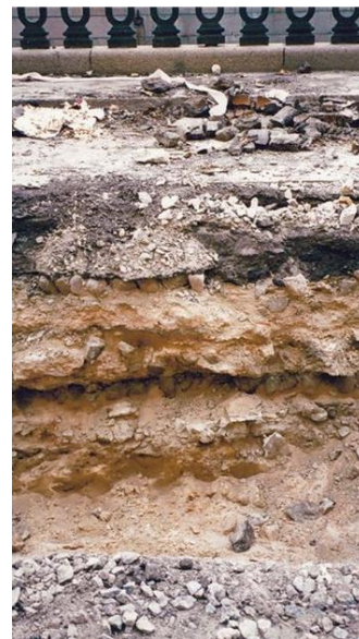
Рис. 3. Напластования материалов дорог разных периодов в Санкт-Петербурге [6] Fig. 3. Layers of road materials of different periods in St.-Petersburg [6]
