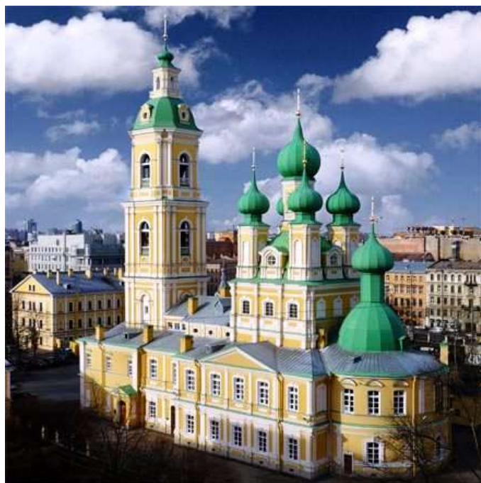
Рис. 4. Церковь Благовещенская Пресвятой Богородицы (1749–1762). Санкт-Петербург, архитектор К.Д. Трезини (?) ( hramblag.spb.ru )
