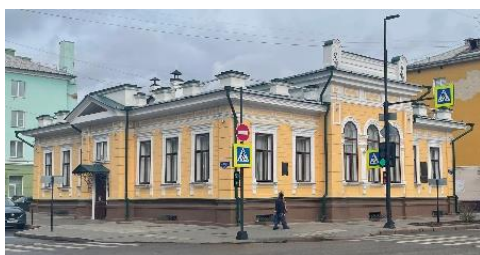
Рис. 8. Деревянный жилой дом усадьбы. Фото Д.В. Прислоновой, октябрь 2022 г.
