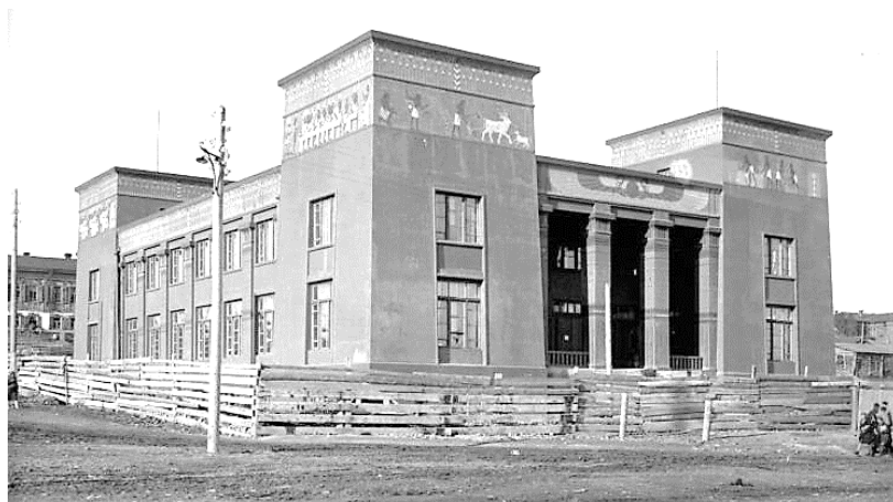
Рис. 8. Красноярский музей в стадии завершения ремонта. 1928–1929 гг. [24, д. 10426/405]
