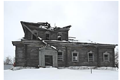
Рис. 10. Церковь Троицкая в с. Старое Шадрино Упоровского района. Фото А.А. Варанкиной, март 2020 г.
