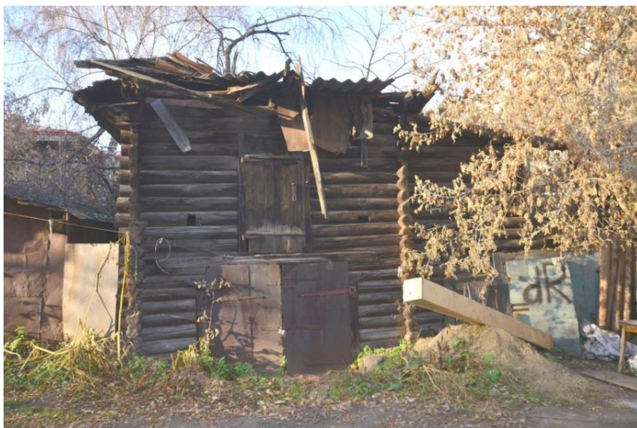
Рис. 5. Фрагмент сохранившейся хозяйственной постройки (служба с навесом) по ул. Дзержинского, 12, в г. Томске. Фото Е.С. Каталевской, 2021 г.
