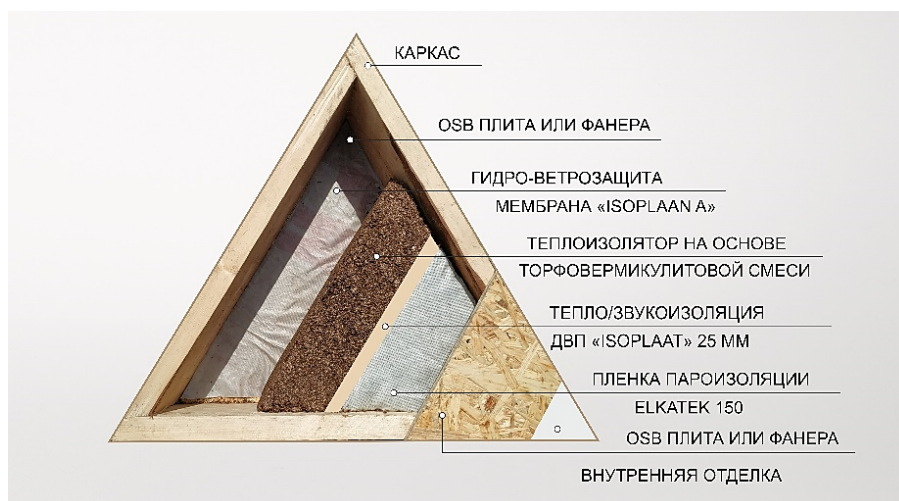
Рис. 1. Устройство наружной стены здания купольной конструкции
